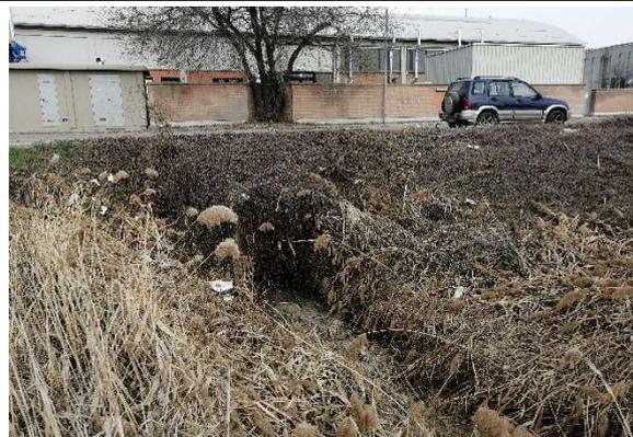
Foto 4 – Inizio del tratto tombato del Rio Spezzano a nord-ovest dell'area in esame, in corrispondenza di via Montegrappa.
