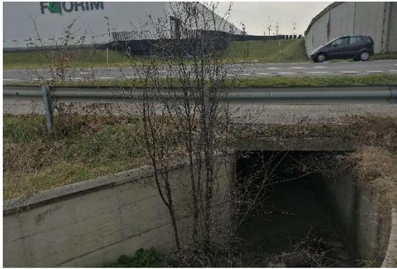
Foto 1 – Vista dello scatolare del rio Spezzano in corrispondenza dell'uscita dell'attraversamento di Strada Pedemontana, proveniente dallo stabilimento Florim (sullo sfondo).
